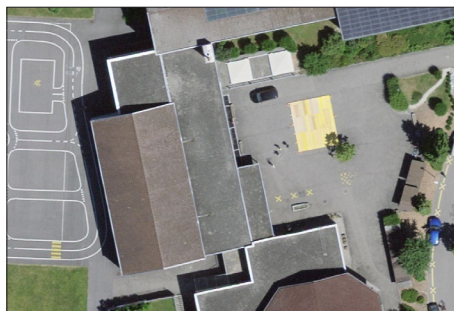
Abbildung 2: Turnhalle Schulstrasse 11, Quelle: VertiGIS
