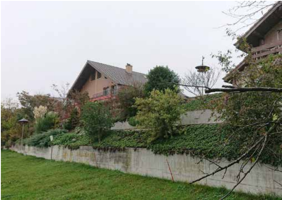
Durchgehende Stützmauer zu den nordseitigen Häusern Wydmatt 8-18
